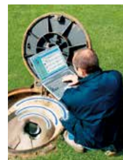
Assistance à la mise en service
