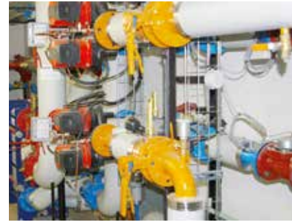
Réseaux de chaleur et d'énergie
