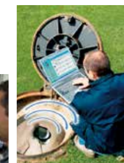
Assistance à la mise en service
